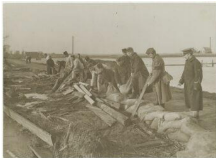
Aanleg nooddijk bij Purmerend in 1916. Foto Noord-Hollands Archief
